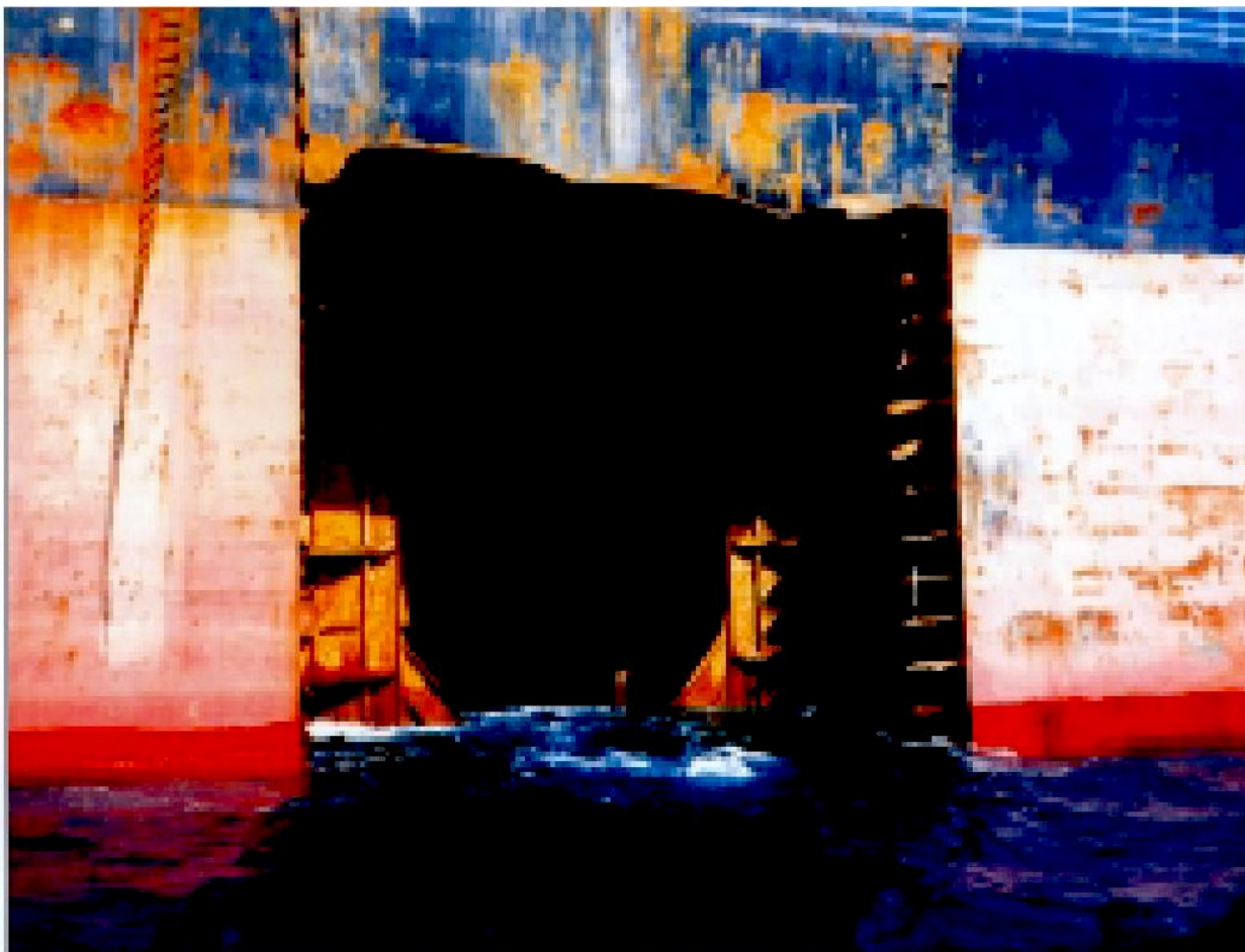
Рисунок 14. Последствия незамеченной коррозии
