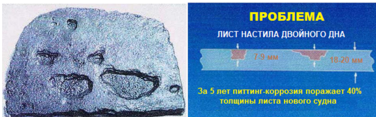
Рисунок 2. Питтинг-коррозия в грузовом танке
